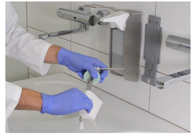
3. Steigrohr der Dosierpumpe mit einem Einwegtuch abwischen.
